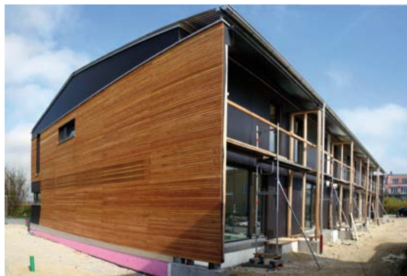
Die Reihenhäuser in Poing: aktueller Bautenstand Oktober 2008.
