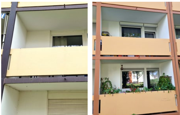
Balkone vor und nach der Sanierung
