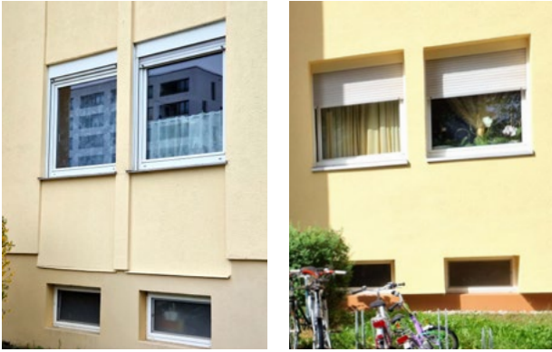
Fenster vor und nach der Sanierung
