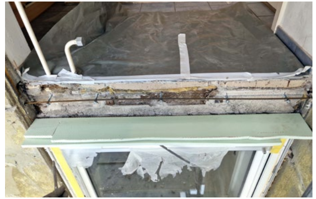
Alter Asbest an den Brüstungen musste neuen, modernen Dämmstoffen weichen.
