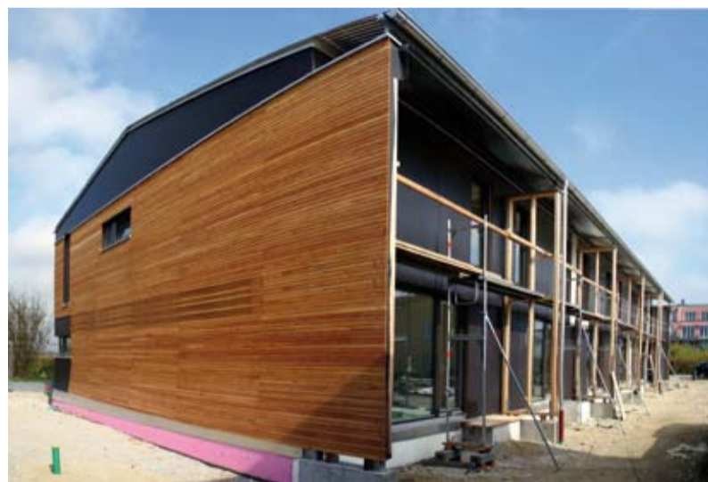
Die Reihenhäuser in Poing: aktueller Bautenstand Oktober 2008.
